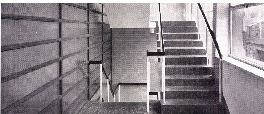
Treppenhaus. Cage d'escalier. Stairwell.
