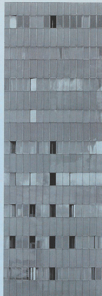
Ausschnitt von einer Fassade des Hochhauses. Die Brüstungselemente sind 60 x 168 cm und die Fensterelemente 60 x 120 cm groß. Das Glas der Brüstungen ist graugrün, die Rahmen sind aus Aluminium.
