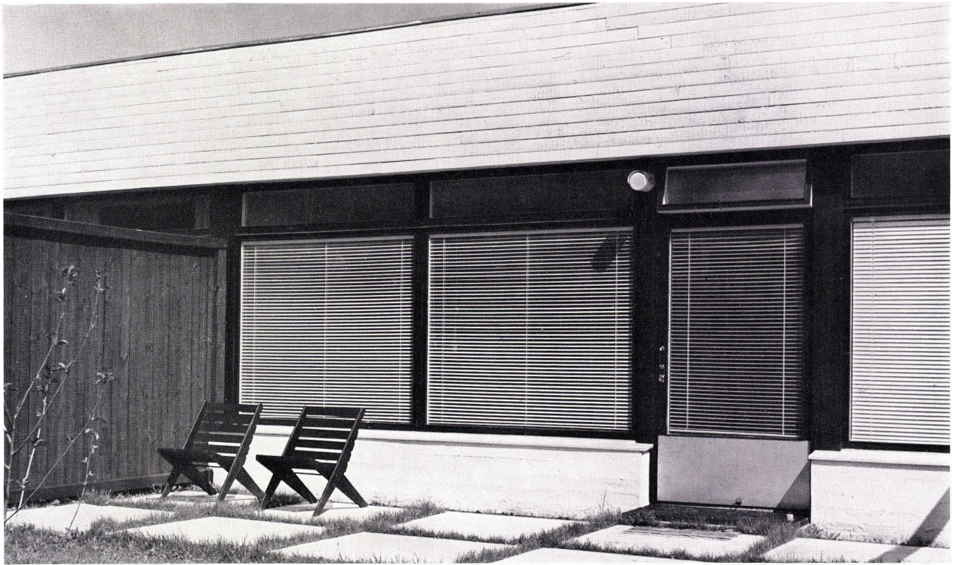
1 Wohnhof von Typ B. Cour de séjour du type B. Residence court of Type B.
