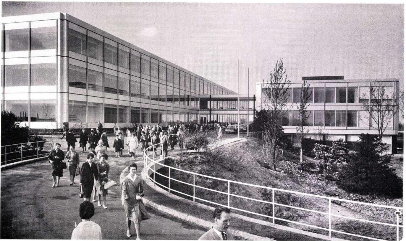
1 Ansicht von Süden auf den Haupteingang. Vue du sud sur l'entrée principale. View from south toward main entrance.
