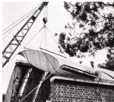
1 Das Fertigelement wird aus der Form gehoben. Un élément terminé est sorti de sa forme. The finished element is lifted from its mould.
