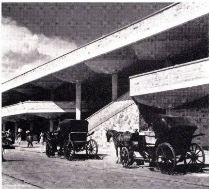
1 Zentrale Halle. Die sattelförmigen Schalen lagern mit ihren beiden Fußpunkten auf Stützen auf, die durch Zugbänder miteinander verbunden sind.
