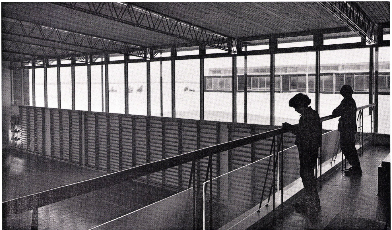
3 Turnhalle, gesehen von einer Galerie aus. Geländer: Teakhandlauf mit Stahlrohrstützen und Plexiglasfüllung. Schwedische Standard-Gitterträger, zwischen denen die Beleuchtung angebracht ist. Halle de gymnastique vue depuis la galerie. Ballustrade: Main-courante tubulaire en teak avec remplissage de plexiglas, sommière standard suédois entrellis, combinés avec l'illumination. Gymnasium, seen from a gallery. Railing: teak handrail with tubular steel supports and plexiglass panelling, Swedish standard girders, between which are the lighting fixtures.
