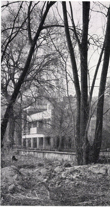
1 Die Seefassade im Winter. La façade du lac en hiver. The lake-elevation in the winter.
