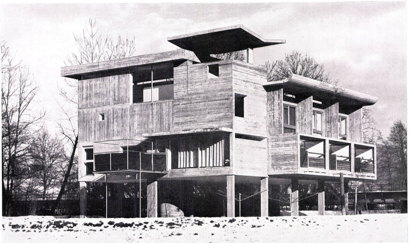
7 West- und Südansicht. Vue des façades ouest et sud. View from west and south.
