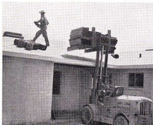
1 Mechanisierung verbilligt den Hausbau in Maryvale
