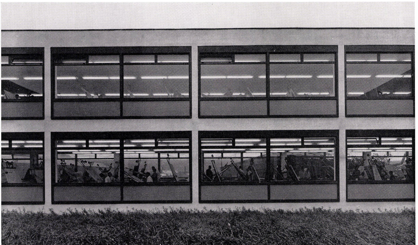
2 Fassadenausschnitt. Sichtbares Stahlbetonskelett, weiß, mit geschobhohen Fensterelementen. Brüstungen aus Polycolorglas. Partie de façade. Squelette de béton armé apparent, blanc; éléments-fenêtres à hauteur d'étage. Allèges en verre polycolor. Elevation detail. Unfaced reinforced concrete skeleton, white, with storey-high window elements. Polycolor glass parapets.
