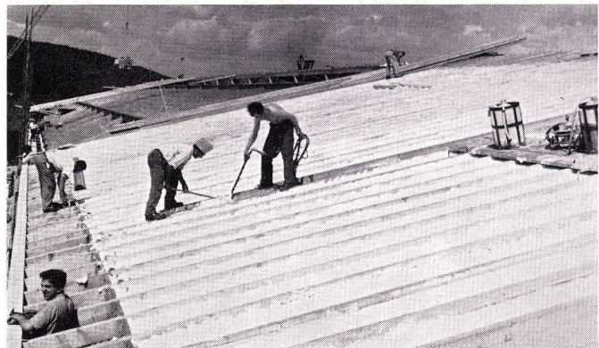
4 Dachisolierung – Aufschäumen von Griso-Spritzschaum zwischen Sparren auf die Schalung.
