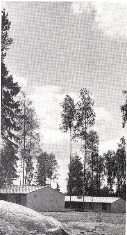
3 Die Gebäude mit Lehrerwohnungen. Les bâtiments avec les appartements des maîtres. The buildings for the masters' residences.
