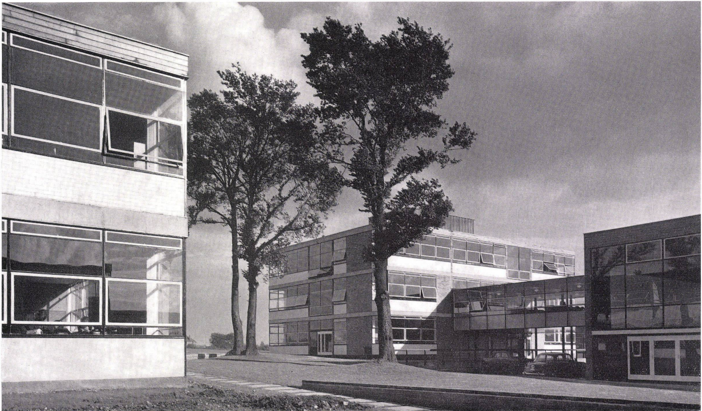
3 Zweiter Hof mit alten Bäumen. Vom zweistöckigen Spezialklassen- und Laborbau, hinten dreigeschossiger Klassenbau und Brücke mit Aulagebäude. Bâtiment des laboratoires et des classes spéciales avec cour ombragée. A l'arrière-plan le bâtiment des classes. Second courtyard with flowers. Seen from the two-story block for special classes and laboratories, behind is the three-storey classroom block and bridge to the assembly hall.
