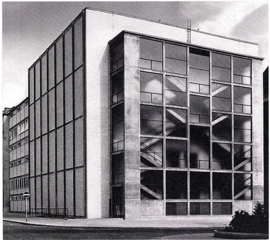
1 Ansicht des Hörsaalgebäudes. Vue de l'immeuble de la salle d'audition. View of the lecture building.
