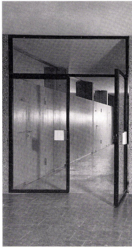
2 Blick vom Treppenvorplatz auf eine Flurwand, die über den eingestellten Schränken verglast ist. Treppenhauswand: gespritzter Beton, Boden: schwarze Beton-Werkstein-Platten. Vue depuis un palier sur un corridor. Paroi de l'escalier en béton. Revêtement du plancher en plaques de béton noires. Looking from access to stairs toward a passage wall, which is glassed above the closets. Stairwell wall: sprayed concrete. Floor: black concrete slabs. 3 Flurwand mit bis zur Decke reichenden Schränken (Limba-Holz), die zwischen die Innenstützen (Sichtbeton) gestellt sind. Parois d'armoires encastrées des corridors. Passage with closets (limba wood) reaching to ceiling, which are placed between the interior supports (raw concrete).
