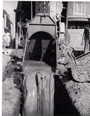
Der mit Bentonit ausgefüllte Schlitz. Überleitung des Bentonitschlammes in den nächsten Grabenabschnitt.
