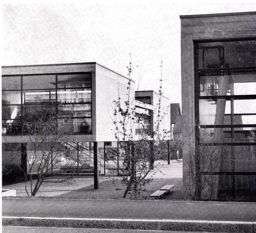
18 Ausschnitt der Nordfassaden der Turnhalle und des Schulhauses. Détail de la façade nord de la salle de gymnastique et de l'école. Detail of north elevations of gymnasium and school building.
