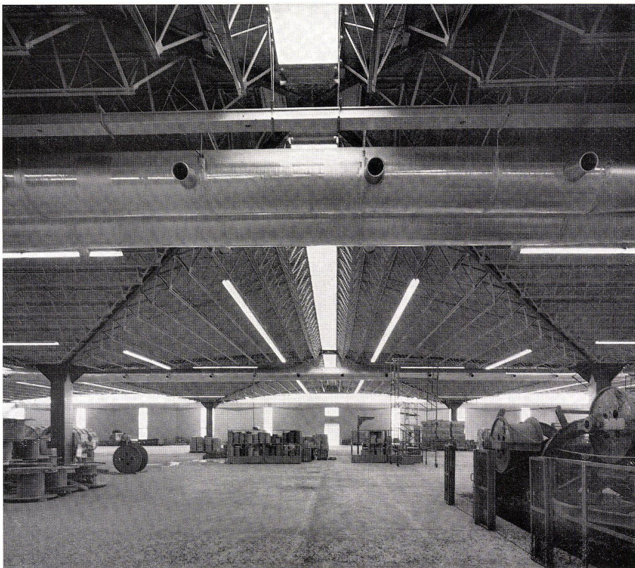
6 Innenansicht mit Oberlichtband und Luftkanal. Vue intérieure avec vitrage supérieur et le canal d'aération. Interior view with skylight strip and the ventilation channel.
