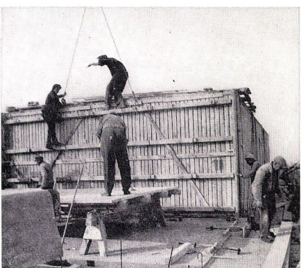
14 Aufrichten der Schalungstafeln mit den an diesen angebrachten Isolierrohren.
