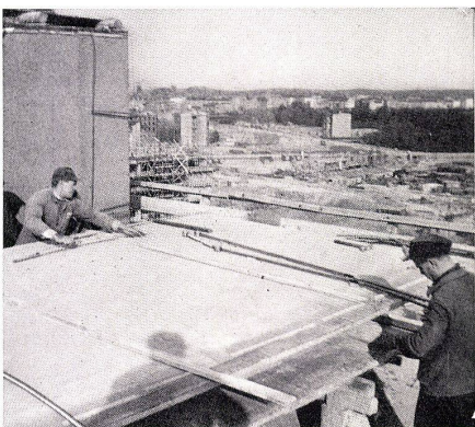
13 Die elektrische Installation der örtlich betonierten Wände wird vor dem Versetzen der Schalungstafeln auf der Schalung befestigt.
