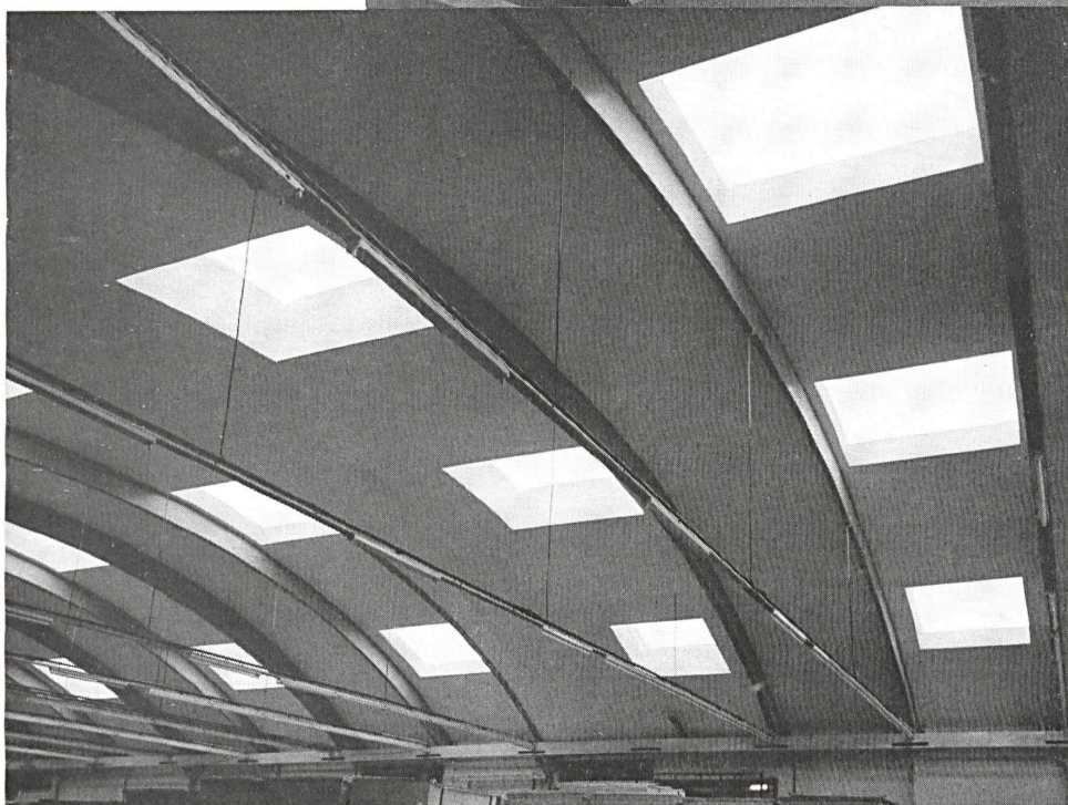
Mortelmans Druckerei und Kartonnagenfabrik N.V. Rijswijk (Holland). Arch.: W. Damen, Den Haag
