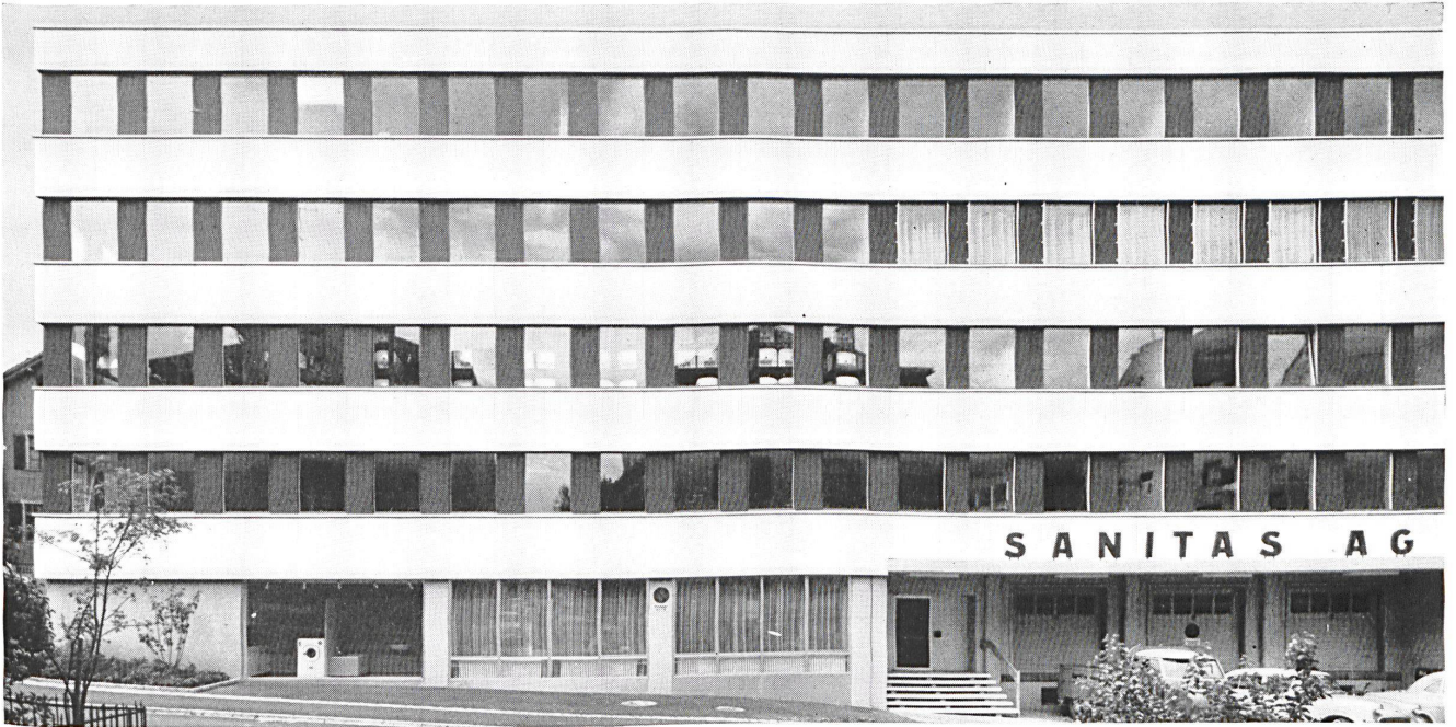
Eternitfassaden System Keller
