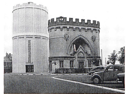
6 Wasserreservoir in Nordfrankreich; es liegen 36 Jahre zwischen der Ausführung der beiden Teile (1925 und 1961); welches ist der alte, welches der neue Teil? Réservoirs d'eau dans le Nord de la France; trente six ans séparent les deux constructions (1925 et 1961); quel est l'ancien, quel est le nouveau? Water reservoirs in Northern France: thirty-six years separate the two structures (1925 and 1961); which is the old one, which the new?
