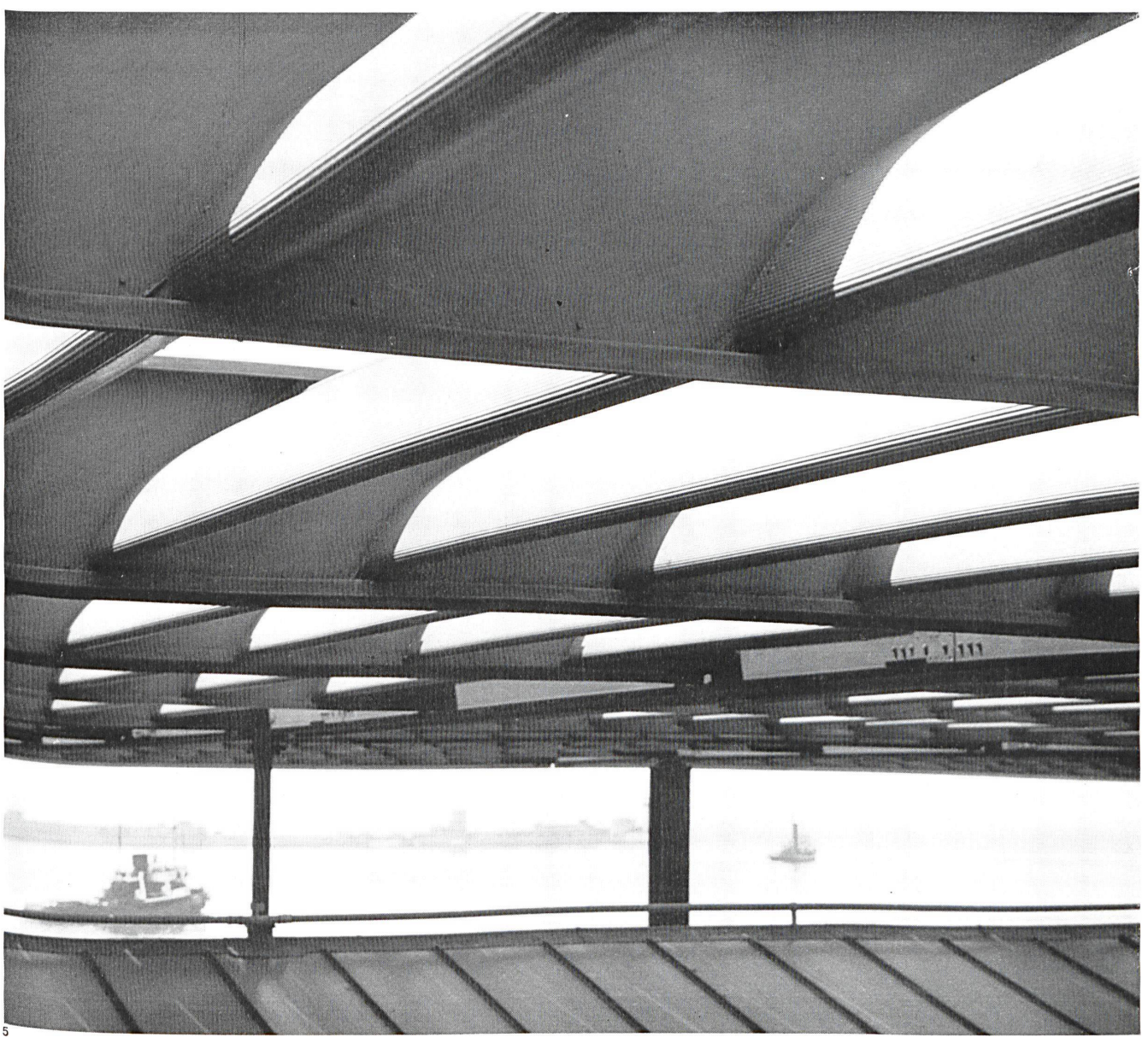
5 Ausschnitt des Sonnenschutzes über dem Glasdach. Détail du brise-soleil en lames d'aluminium au des- sus de la verrière. Detail of the aluminium-slatted brise-soleil above the window.
