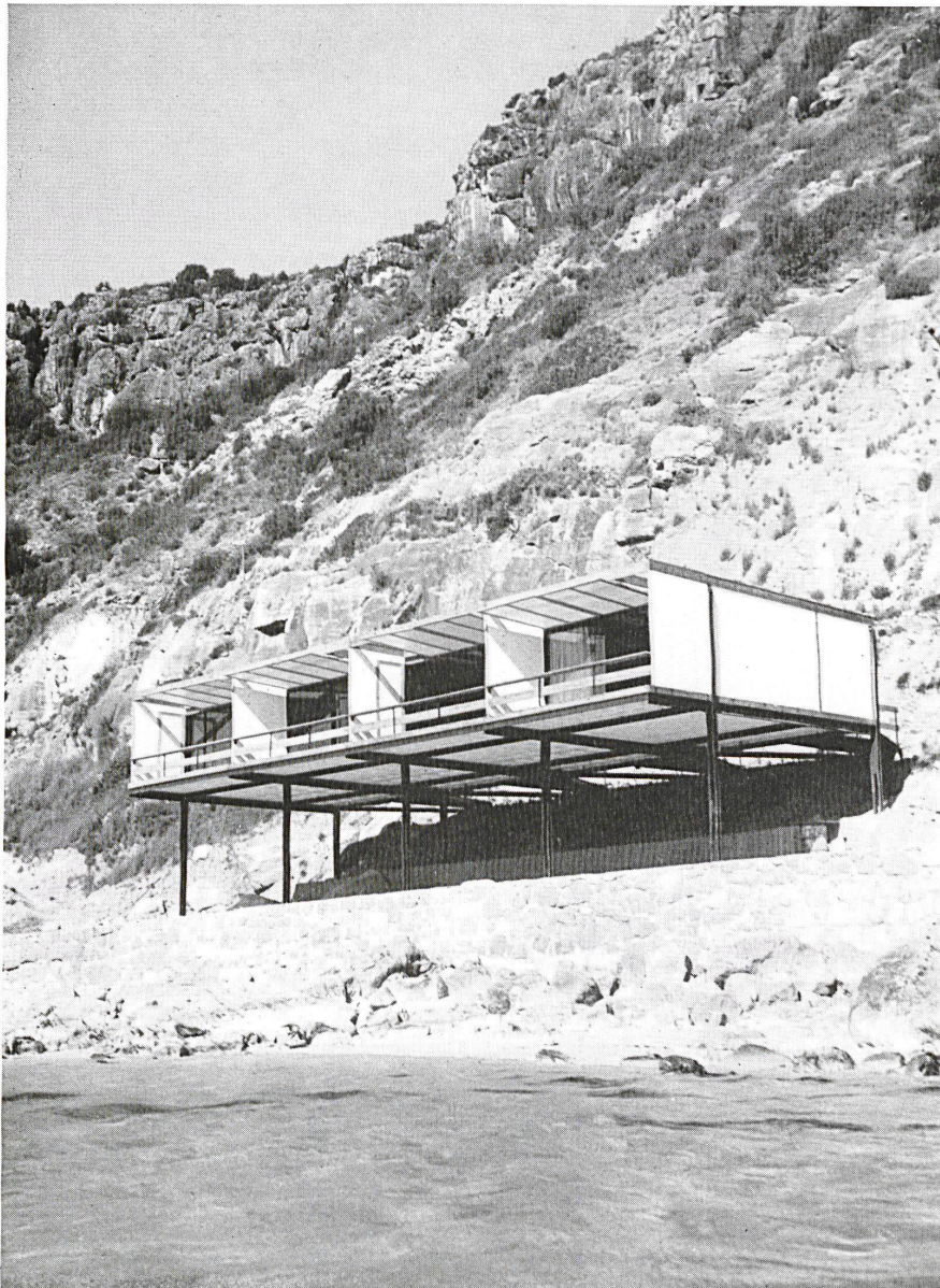
2 Seitenansicht vom Strand aus. Eine sehr schlanke Stahlkonstruktion trägt die Häuser. Vue depuis la plage. Les maisons sont portées par un squelette en acier très mince. Lateral view from the beach. A very slender steel construction carries the houses.
