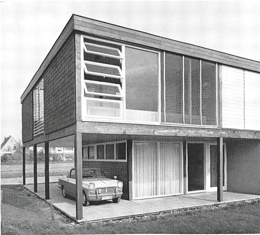
1 Nordwestecke, unten Eßzimmer mit Außensitzplatz, oben Kinderzimmer. Die Sonnenblenden schließen die Loggia vollständig ab.
