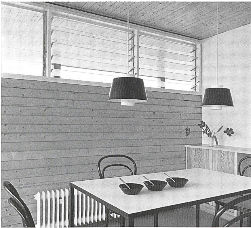
1 Das kleine Eßzimmer hat hochliegende Fenster mit Lamellenlüftungsfenstern. Decke und Wand Kiefern-schalung, hellblauer Klebeboden.
