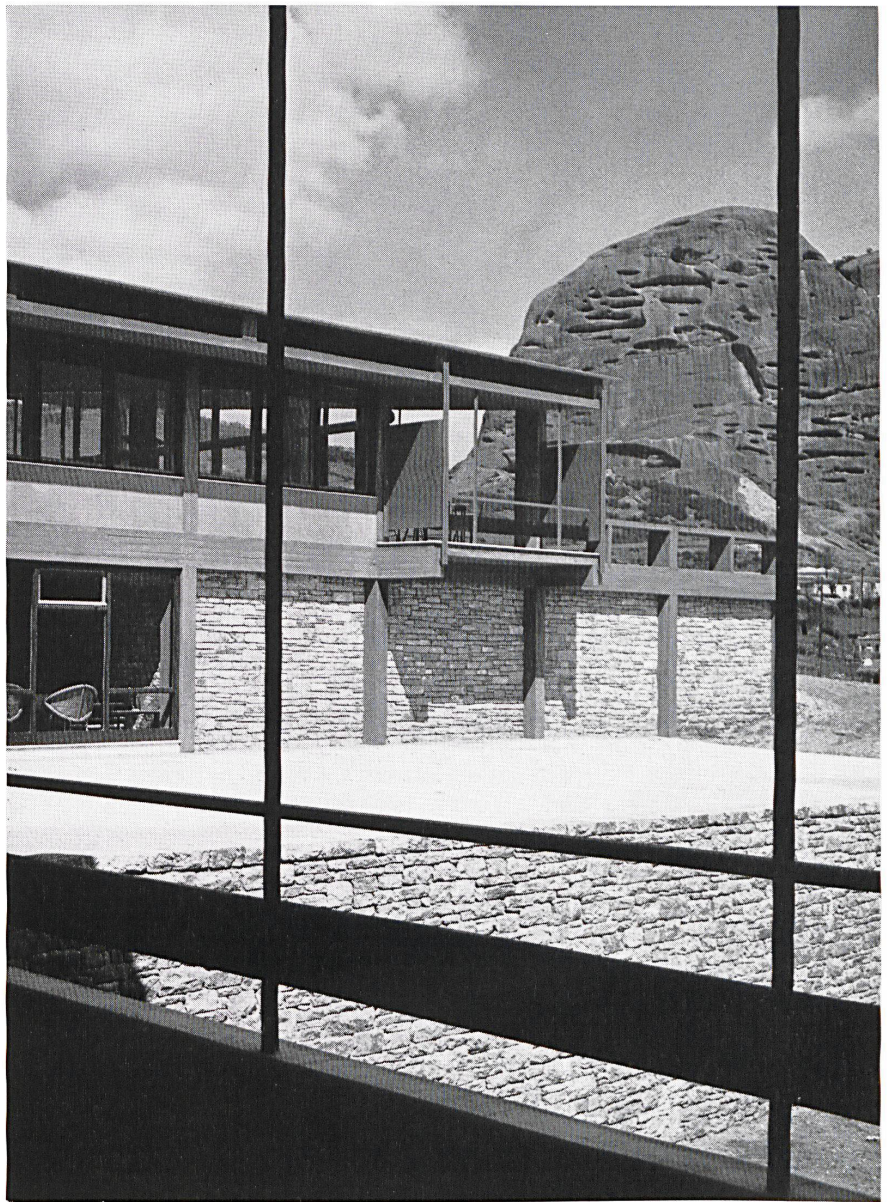
1 Blick vom Verbindungsbau zum Restaurant und dem Erdgeschoßsalon. Eisenbeton und Bruchsteinmauerwerk bestimmen das äußere Gesicht des Bauwerkes. Vue depuis le volume de liaison vers le restaurant et le salon au rez-de-chaussée. L'aspect extérieur du bâtiment se détermine par le béton brute et par des murs en pierre de taille. View from the connecting tract toward the restaurant and the ground floor lounge. Reinforced concrete and quarry-stone masonry determine the exterior aspect of the structure.
