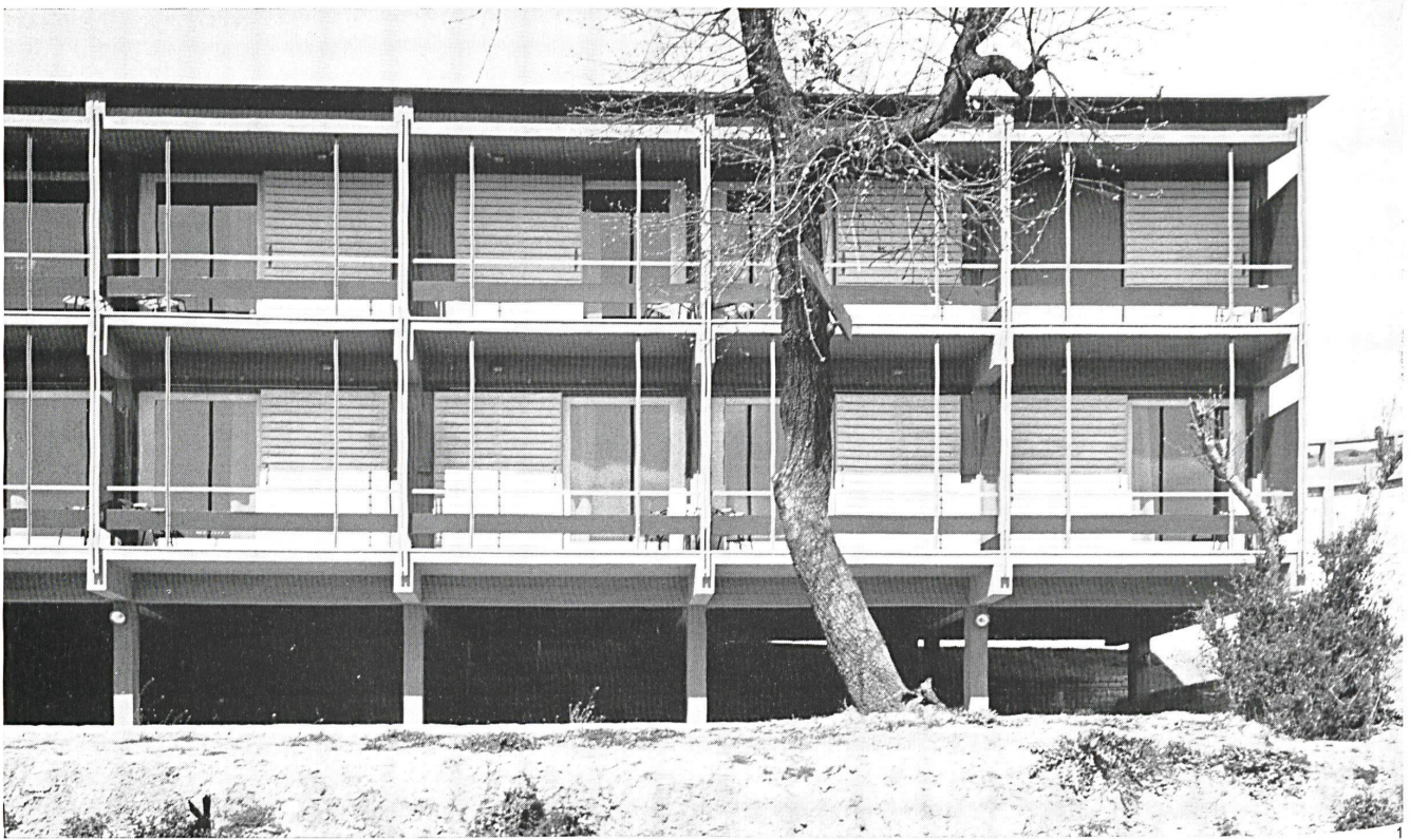
1 Zimmertrakt. Die Schiebeläden sind alle geöffnet. Unter den Zimmergeschossen die Autoabstellplätze des Motels. Volume des chambres. Les volets coulissants sont tous ouverts. Sous l'étage des chambres se trouvent les places pour les voitures. Bedroom tract. The sliding shutters are all opened. Beneath the bedroom floors are the parking facilities of the motel.
