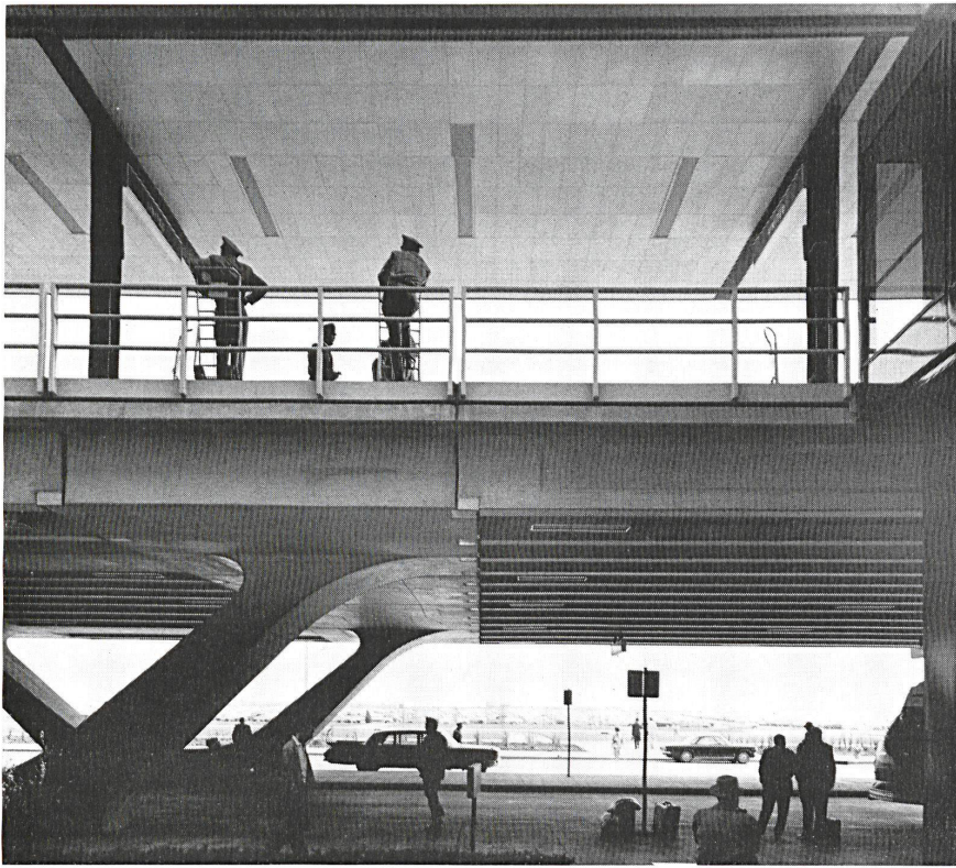
1 Die zweistöckige Zufahrt der Terminusbauwerke, Autozu- und -abfahrt oben und unten. Blick auf den großen zentralen Parkplatz. L'accès des véhicules sur deux niveaux de l'aéroport. Vue sur le grand parking. The two-storey access to the terminal buildings, entrance and exit for cars above and below. View on to the large central parking area.
