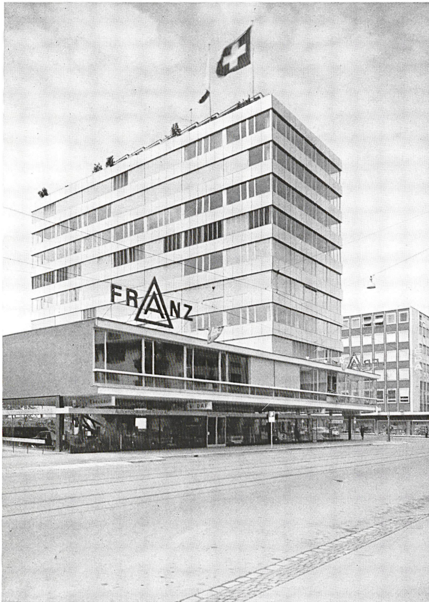
Neubau Automobilwerke Franz AG, Zürich 3 W. Stücheli, dipl. Architekt BSA/SIA, Zürich
