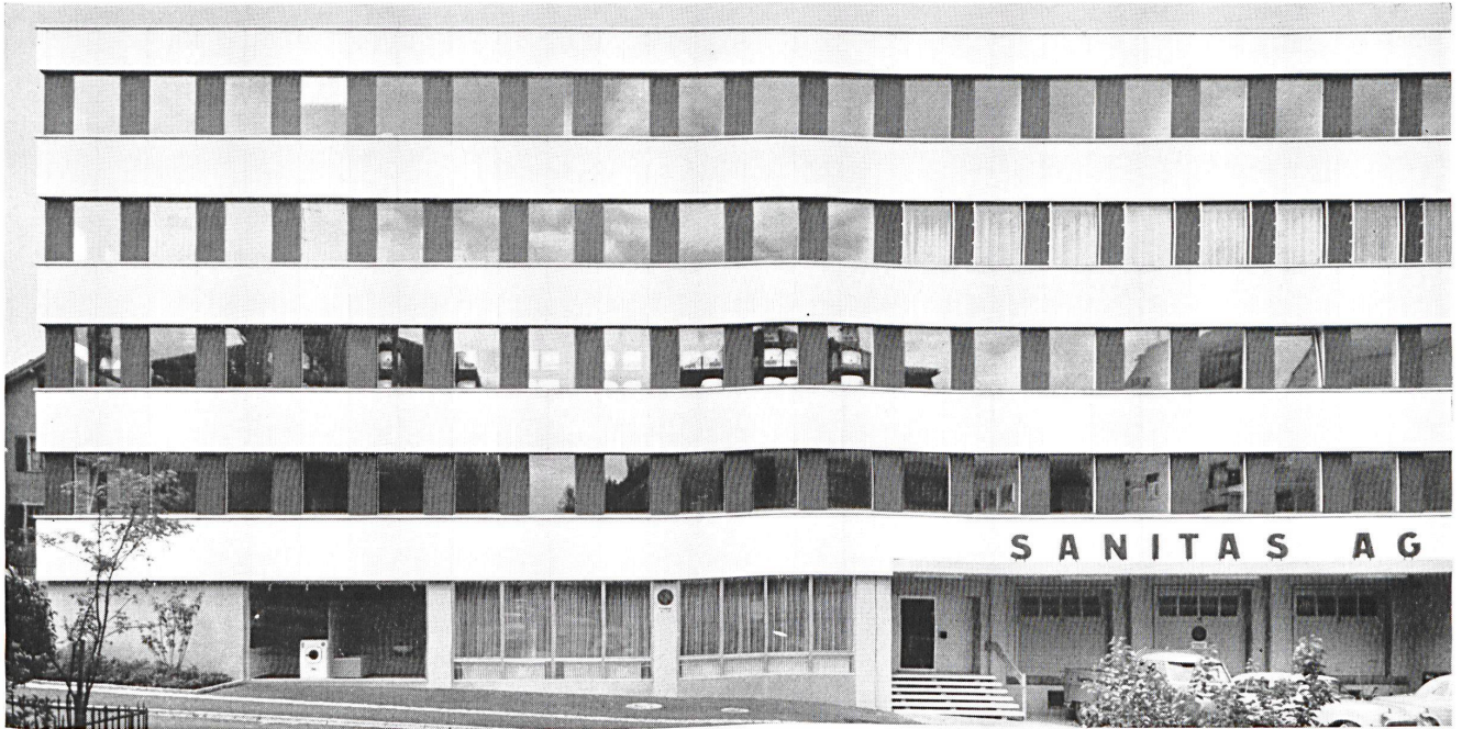
Eternitfassaden System Keller
