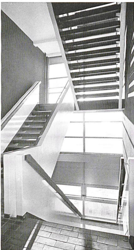
3 Treppen aus vorfabriziertem Stahlbeton. Escaliers en béton armé préfabriqué. Stairways in pre-fabricated reinforced concrete.
