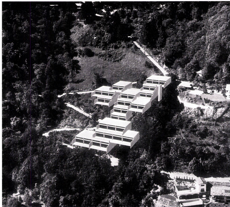
Perspektive der ganzen Anlage (Photomontage). Perspective de l'ensemble (montage photographique). Perspective of the entire complex (photomontage).
