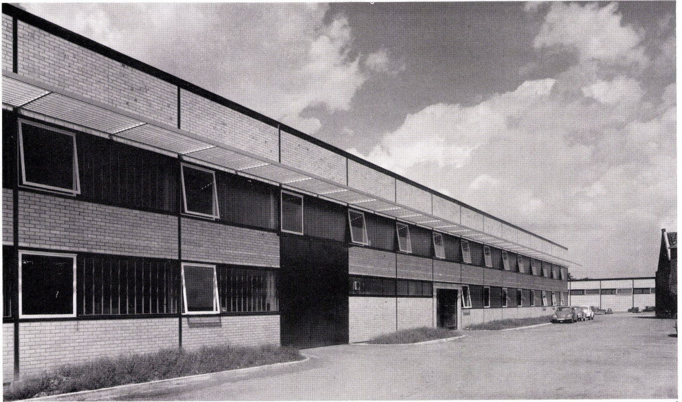
1 Südseite der Fabrikationshalle mit Sonnenschutz für die auf einer Empore angeordneten Büroräume. Im Hintergrund Stahlagerhalle mit vorgelagertem Gußplatz. Face sud de la halle de fabrication avec pare-soleil pour bureaux en estrade. En arrière-plan la halle magasin des aciers avec fonderie. South side of the production shed with brise-soleil for the offices on raised level. In background, steel stores with foundry in front.
