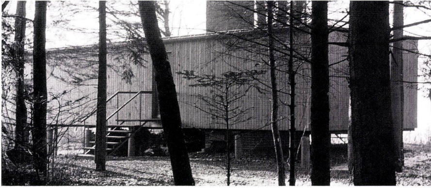
3 Die Westfassade von der Liegewiese aus. La façade ouest vue de la pelouse. The west face from the lawn.
