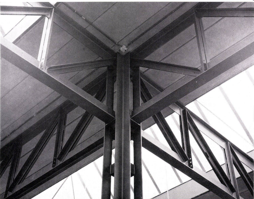
1 Innenansicht Fabrikationshalle Metallabteilung. Im Deckenrost eingehängter Kranbaum. Vue intérieure de la halle de fabrication: section des métaux. Grue accrochée à la grille porteuse. Interior view of fabrication hall showing metal department. Note crane built into ceiling gridwork.
