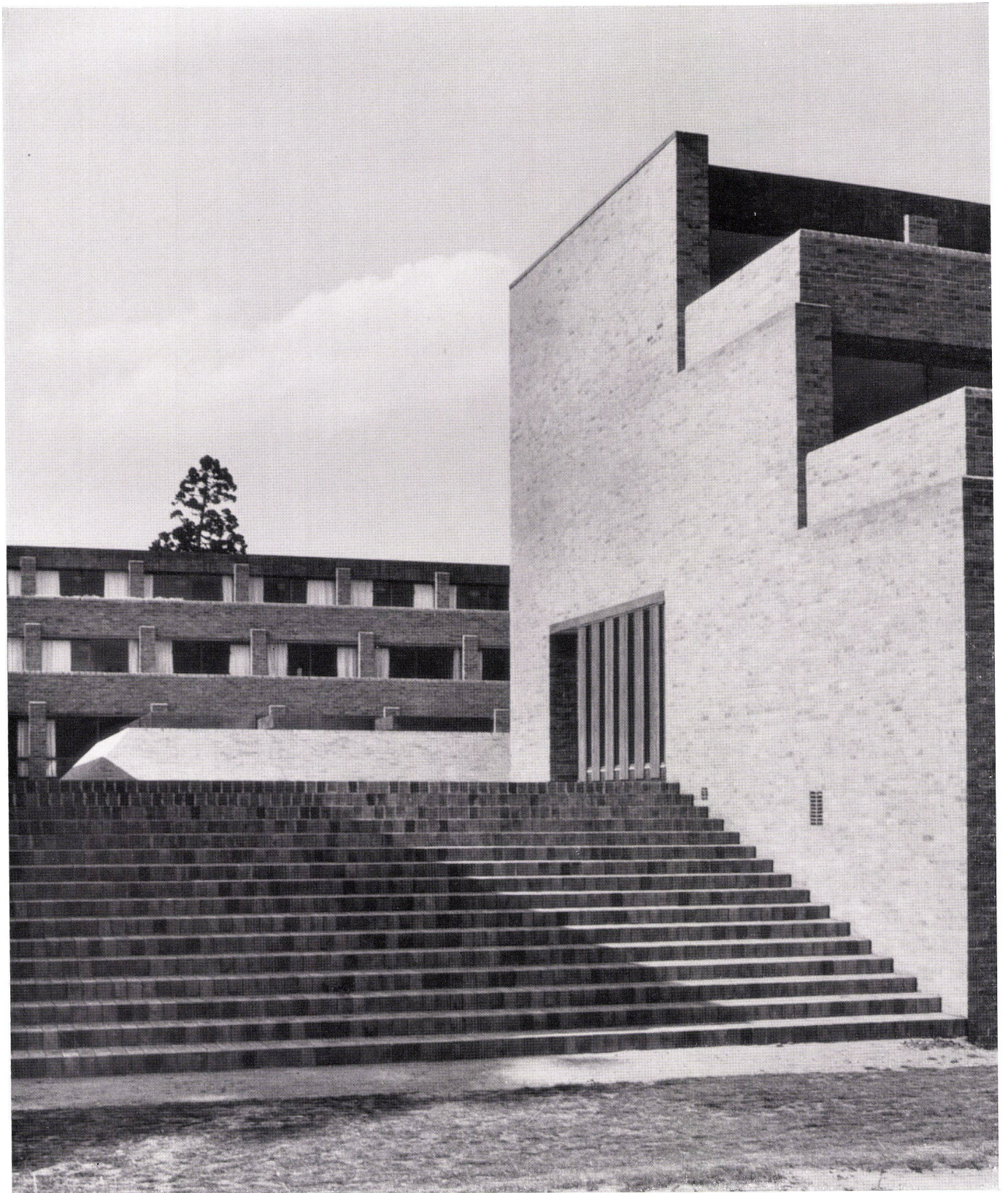
Abgang zum Park. Descente vers le parc. Descent to park.
