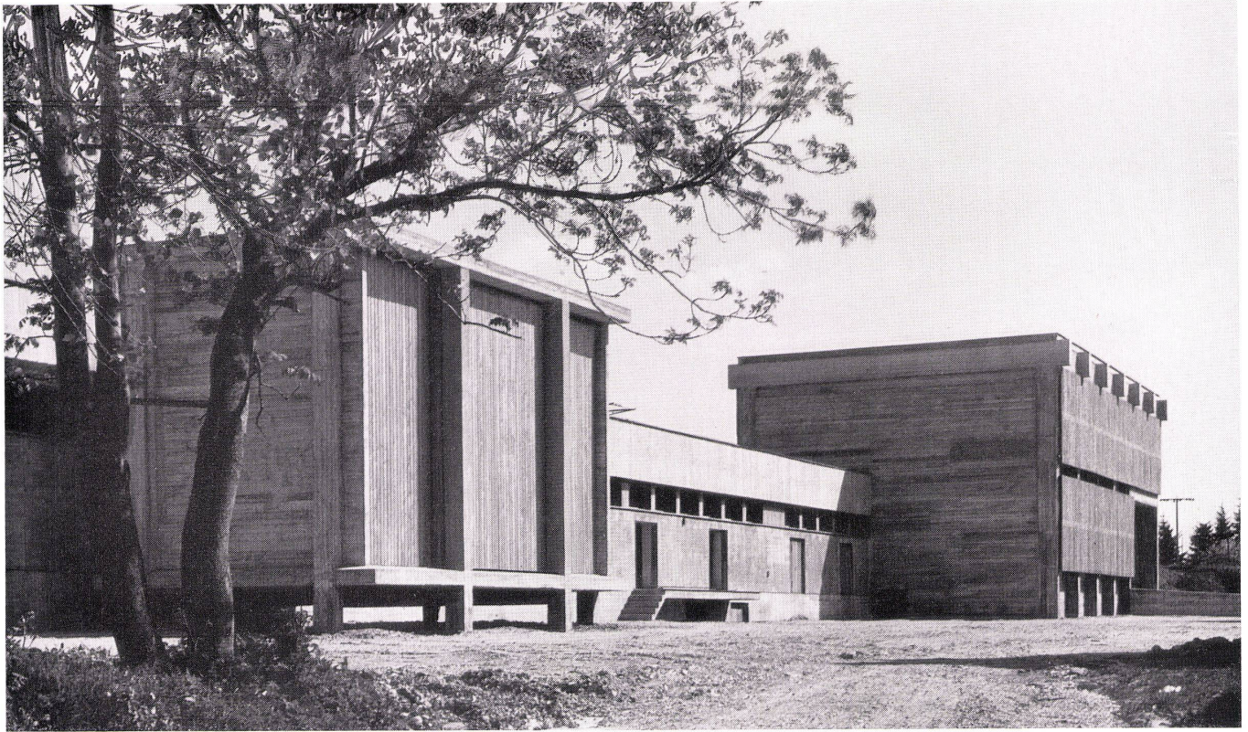
Rinderstall, Westseite. Etable des bœufs, côté ouest. Cattle stable, west side.
