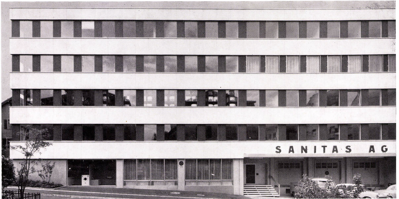
Eternitfassaden System Keller
