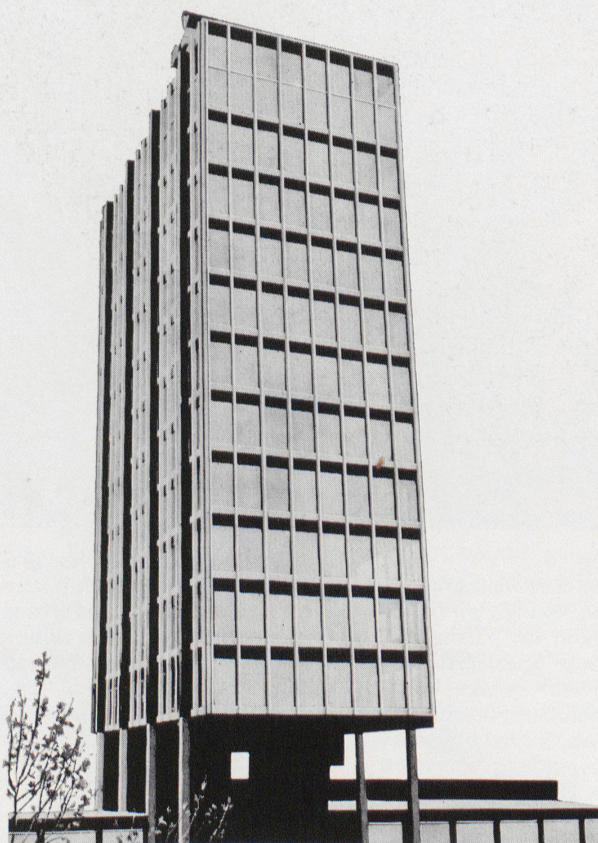
Imprimeries Réunies - Lausanne. Architekt: J.-M. Lamunière
