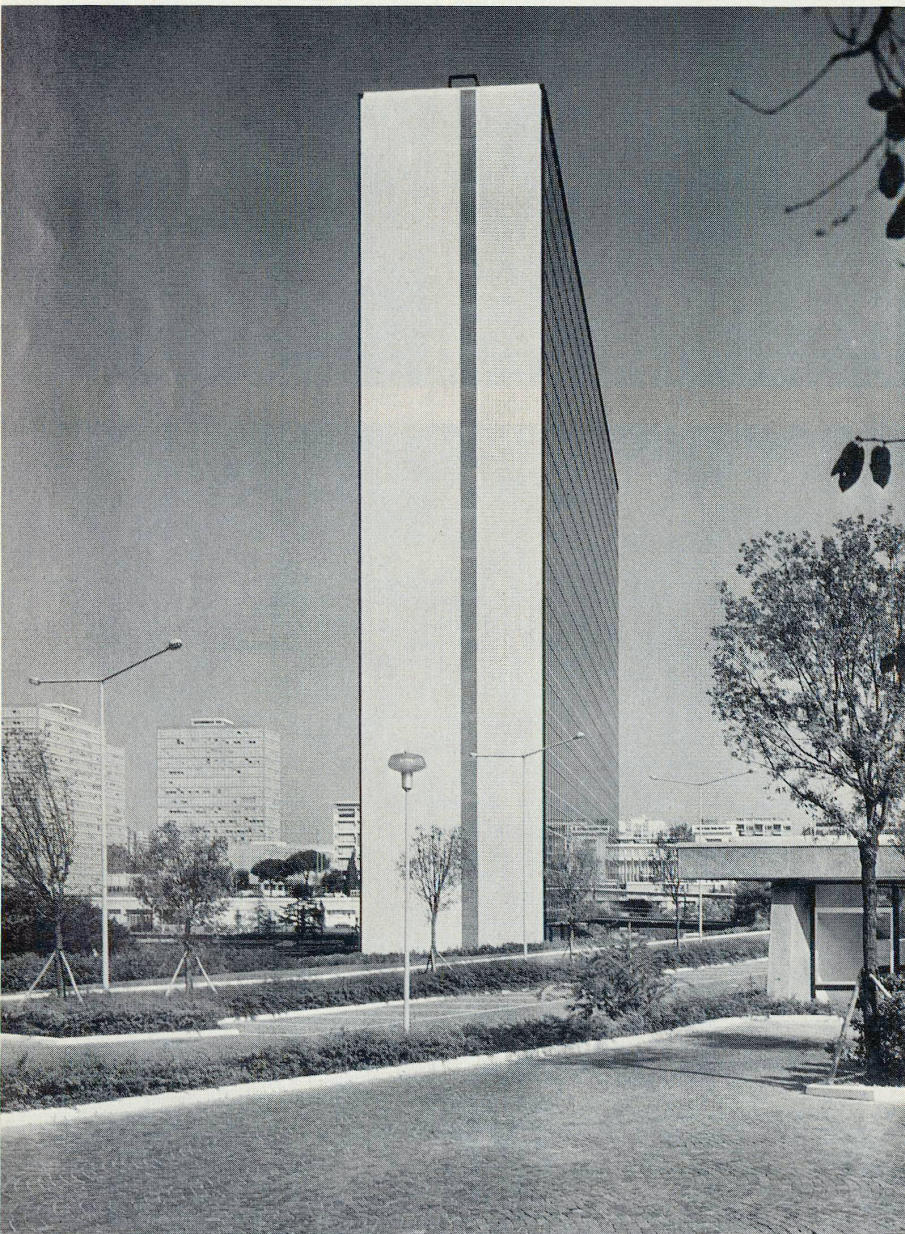
1 Südost-Ecke. Im Vordergrund die Betriebsmensa. Angle Sud-est. A l'avant-plan la cantine. South-east corner. In foreground, the canteen.
