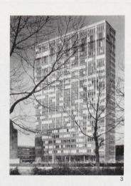
Das 80 m hohe Kernbauwerk konnte dank Gleitschalungen in 44 Tagen fertig betoniert werden.
