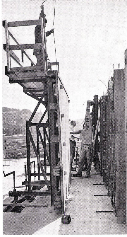
2 Nach eingebauter Armierung wird die Schalung geschlossen. Fermeture du coffrage après la pose de l'armature. The coffering is sealed after reinforcement is built in.
