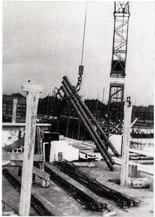
6 Fertigung großer Wandelemente im fliegenden Betrieb.
