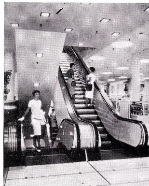
3 Fahrtreppenbatterie im College Grove Shopping Center in San Diego, USA.
