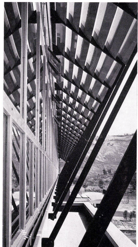
3 Um die Fensterfront vor den Sonnenstrahlen zu schüt- zen, sind Brises-soleil angebracht. Brise-soleil protégeant le vitrage du restaurant. Brises-soleil are attached along the front of the build- ing.
