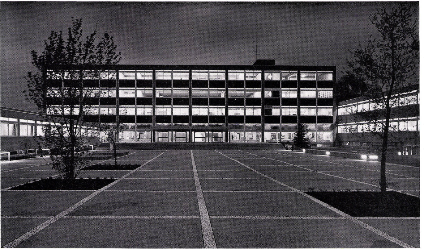
1 Bei Nacht bietet die Schule ein festliches Bild. Platzleuchten begleiten die Treppen und den Sommerhof. De nuit l'école offre un spectacle éblouissant. Des lampadaires accusent les escaliers et la cour d'été. The school by night offers a festive spectacle. Stairways and the summer courtyard are illuminated.
