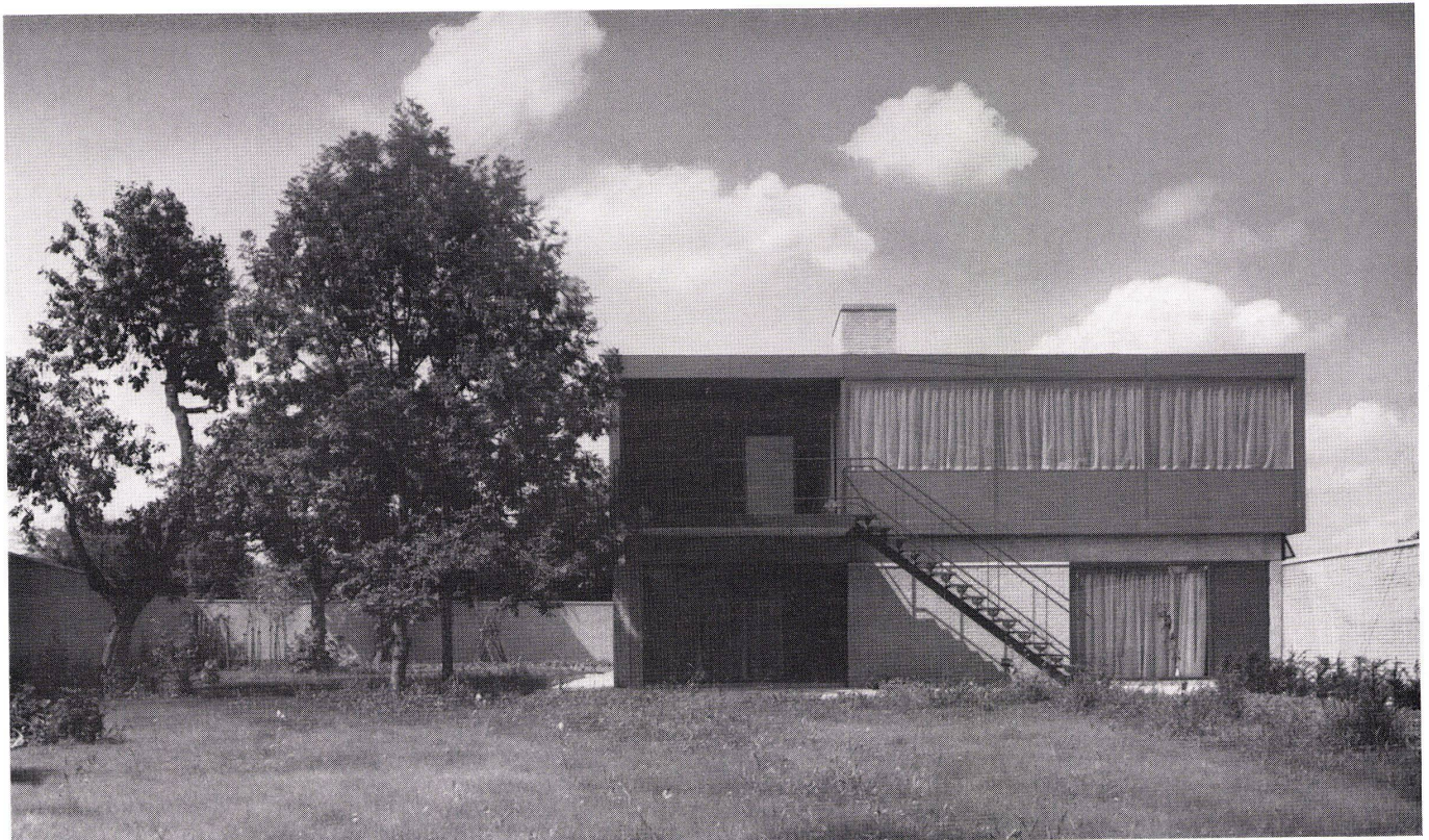
3 Die Schmal- und Gartenseite des Direktorhauses mit der Treppe, die vom Wohnraum in den Garten führt. Face étroite de la maison du directeur donnant sur le jardin par un escalier depuis le séjour. Gable end of the Housemaster's house showing the stairway leading from living room into the garden.
