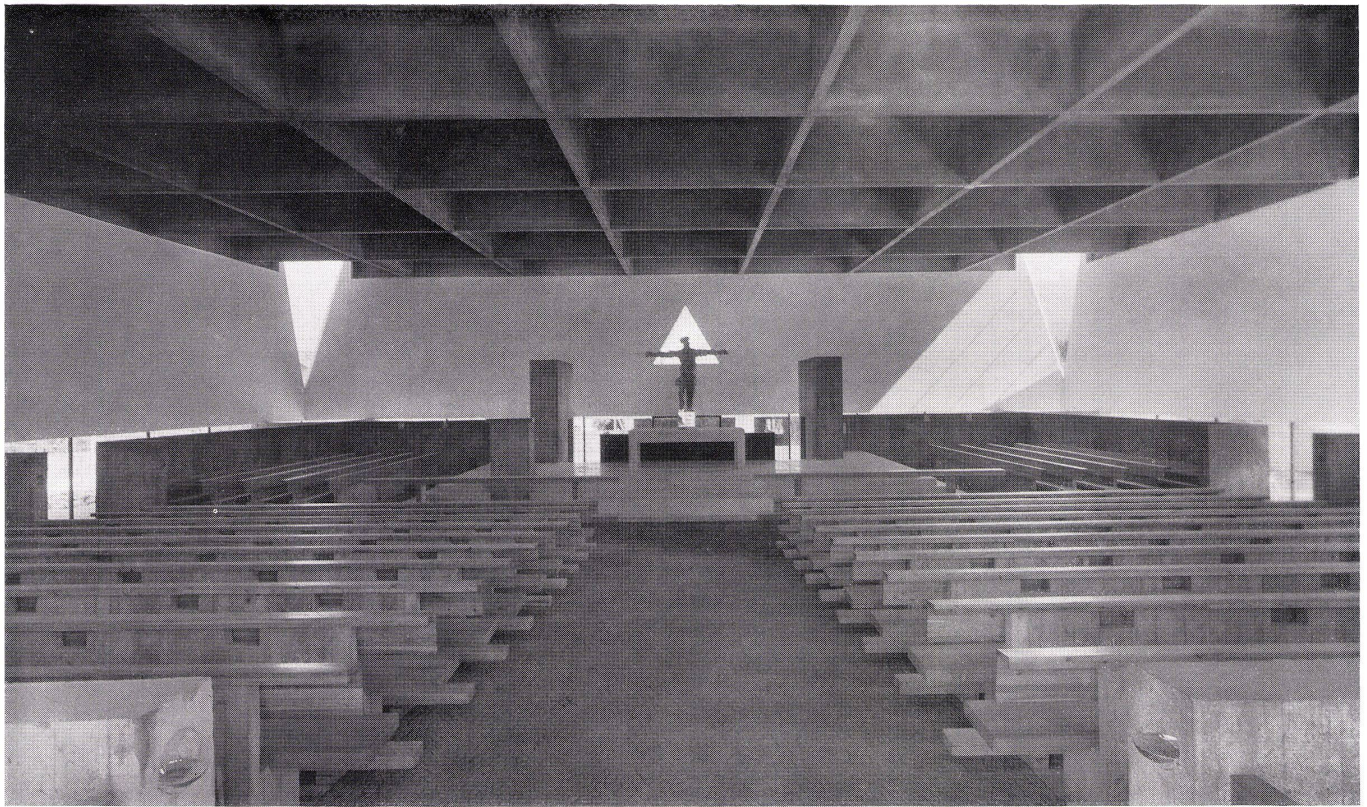
1 Innenansicht, vom Haupteingang aus. Aspect intérieur, depuis l'entrée principale. Inside view, seen from main entrance.
