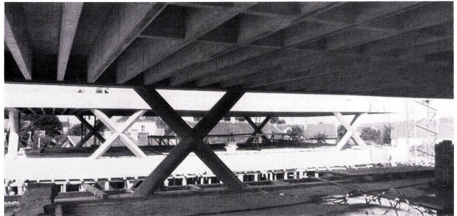
3 Stahlbetonstruktur mit Untersicht. Structure en béton armé avec vue des dessous. Reinforced concrete structure as seen from below.
