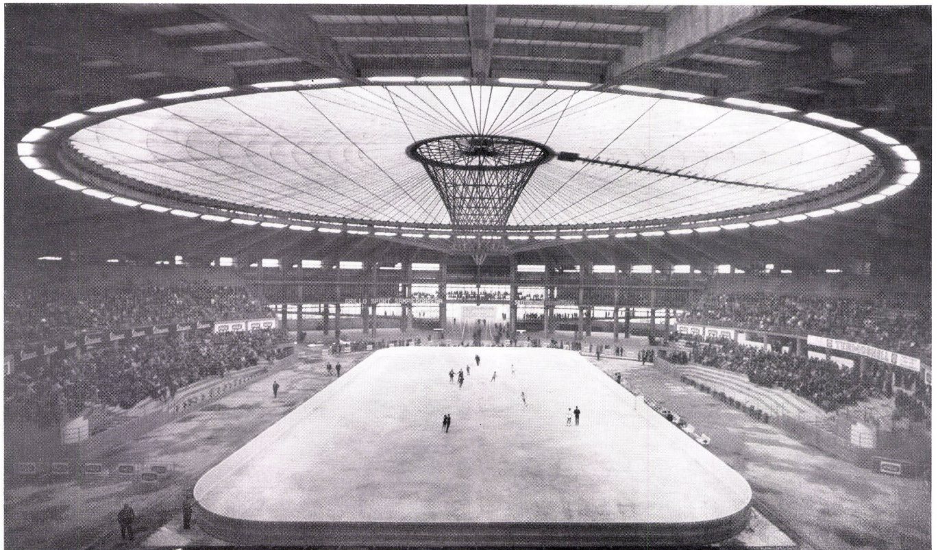
4 Innenansicht. Vue intérieure. Inside view.
