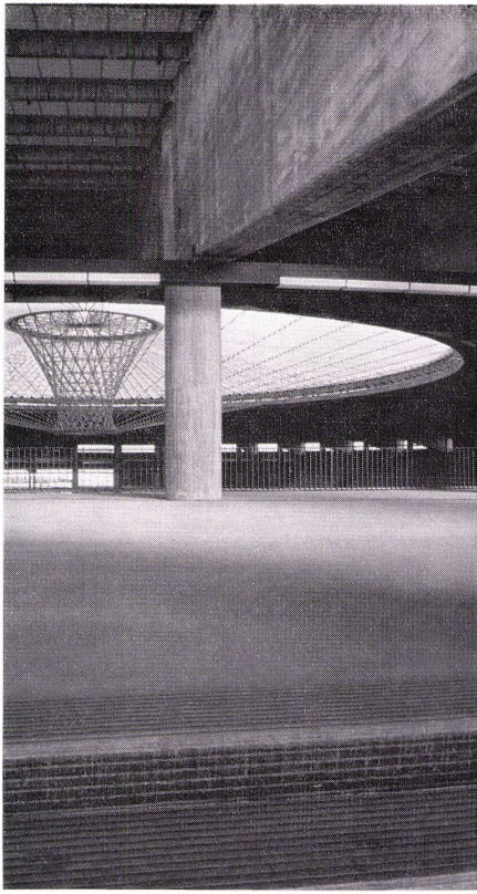
1 Blick vom Zwischengeschoß. Vue depuis l'entresol. View of the sports field.
