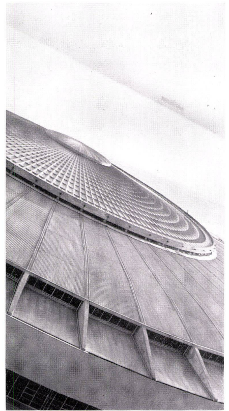
3 Detail der Dachhaut. Der mittlere Ring ist mit licht- durchlässigen Kunststoffplatten bedeckt. Détail de couverture. L'anneau central est recouvert de plaques translucides en matière synthétique. Detail of roofing: middle ring covered with trans- lucent plastic slabs.
